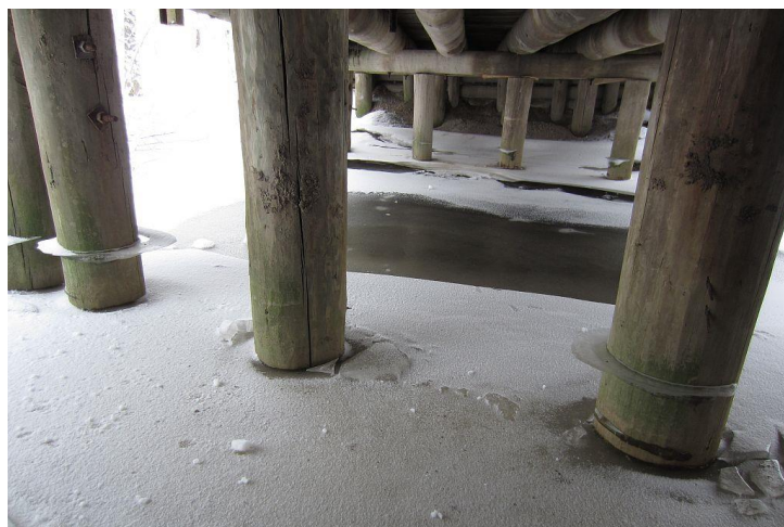
Kuva 11 Saukko suosii kuivapolkua sillan alituksessa. Ylempänä kuva radan alikulku Jorvaksessa ja alempana Lustikullan silta, jonka alta löytyi saukon jätöksiä talvella 2013. SP
