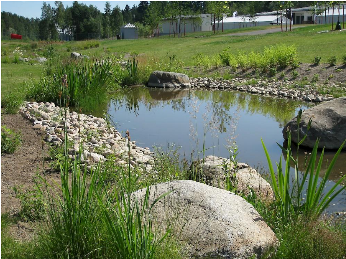
Kuva 12 Esimerkki huleveden tasa-altaasta Kuopion asuntomessualueella. © Viherympäristöliitto.
