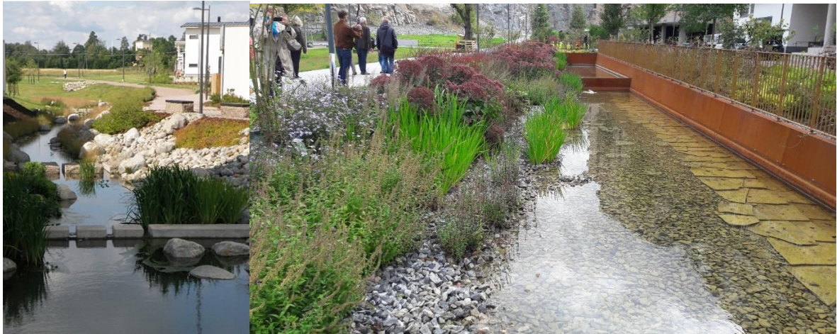
Kuva 13 Hulevesien johtamiseen ja virtaaman viivyttämiseen tarkoitettuja avouomia pohjoismaisissa kaupungeissa.
