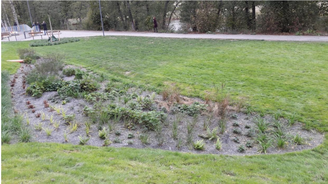
Kuva 16 Esimerkki hulevesien biosuodatuskentästä kerrostaloalueella Tukholmassa. Kenttä on toteutettu pilaantuneelle maaperälle eristämällä rakenne ympäröivästä maaperästä bentoniittimatolla. Vedet johdetaan rakenteen pinnalle tulevalla purkuputkella puhdistumaan.
