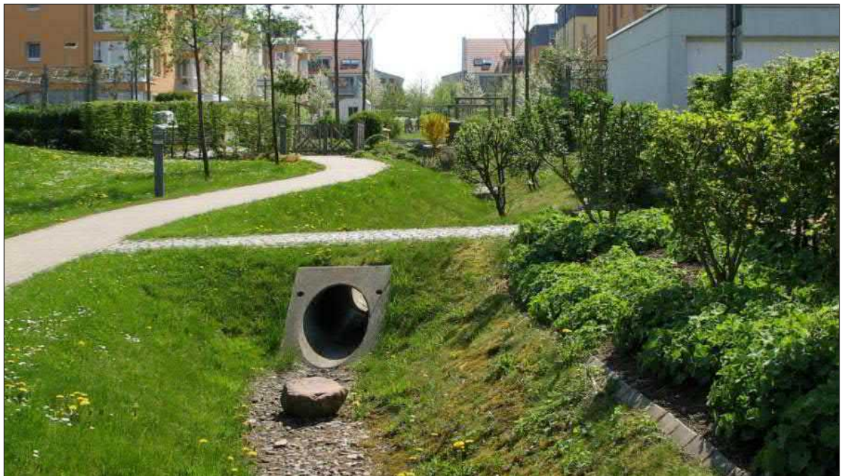
Kuva 23. Avo-oja yleisellä puistoalueella johtaa asuinalueen hulevedet. 9
