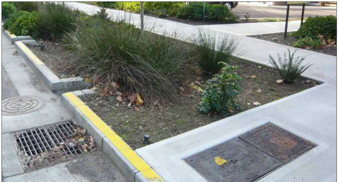
Kuva 22. Katualueen hulevesien hallintaa vihertaskuilla. 9
