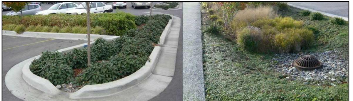
Kuva 16. Vasen kuva: Pysäköintialueen viherpainanne, jonne hulevedet ohjataan maanpinnalla reunakivien aukoista. Oikea kuva: Esimerkki viherpainanteen ylivuotojärjestelmästä hulevesiviemäriverkkoon. 9
