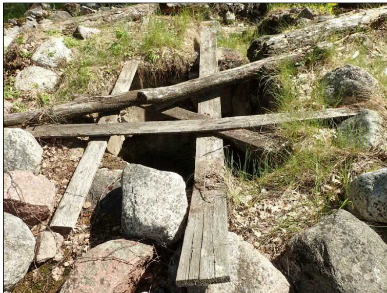
Katolla oleva aukko, siinä betoniseinät.
