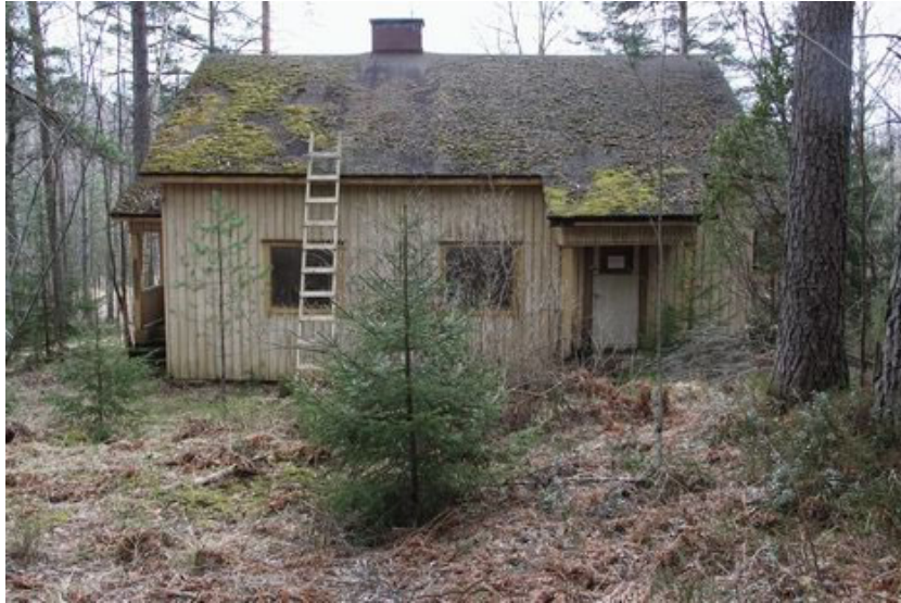
Alueen purkukuntoinen asuinrakennus 1950-luvulta.
