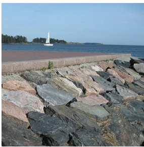
Rantaraittia porrastetaan ja jäsennellään kivikorimuurien, luonnonkiveysten ja luonnonkivireunusten sekä louhektivistä tehtyjen luiskien avulla
