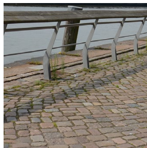
Rantaraittia porrastetaan ja jäsennellään kivikorimuurien, luonnonkiveysten ja luonnonkivireunusten sekä louhektivistä tehtyjen luiskien avulla
