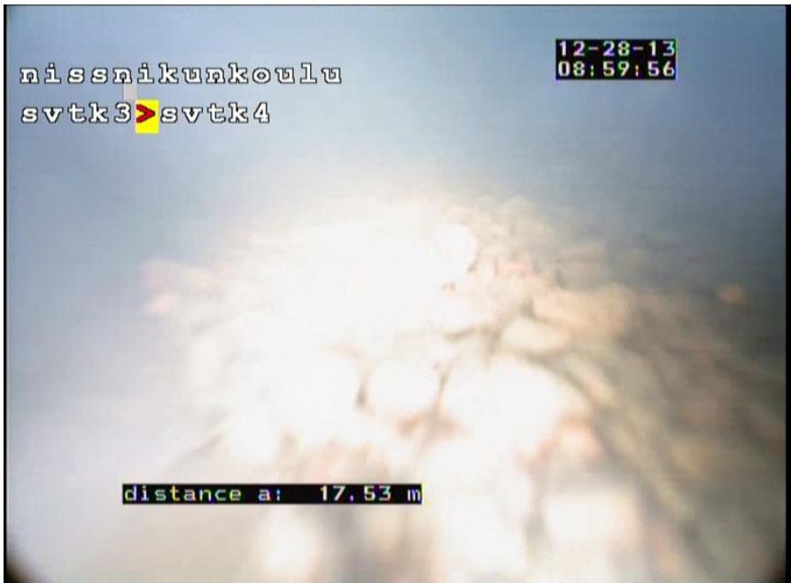
Sadevesiviemärissä paljon kiviä.
