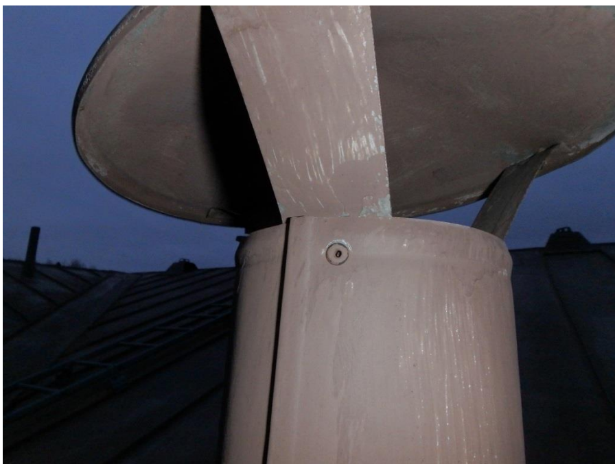
Sadehattu kiinnitetty niiteillä.
