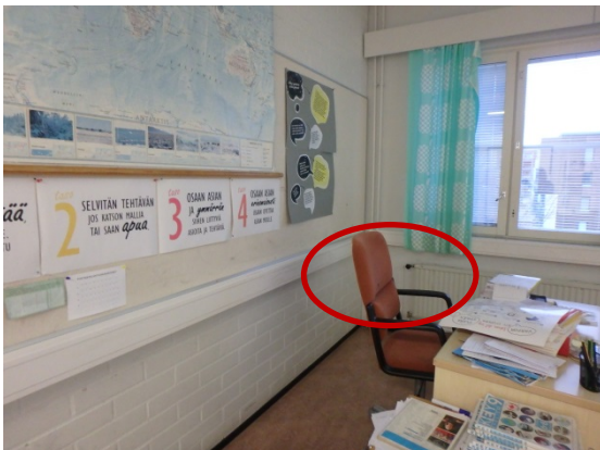
Kuva 24. Koira ilmaisi väli- ja ulkoseinän liitokseen.
