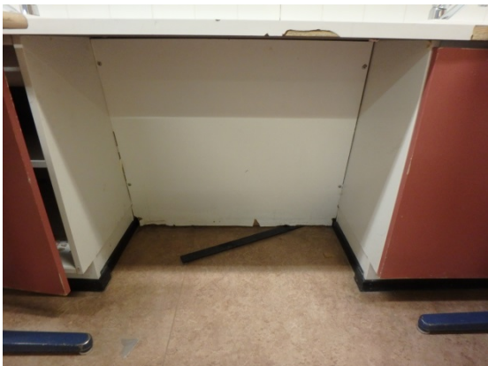
Kuva 6. Koira ilmaisi alaosistaan kosteusvaurioitunutta kalustetta.
