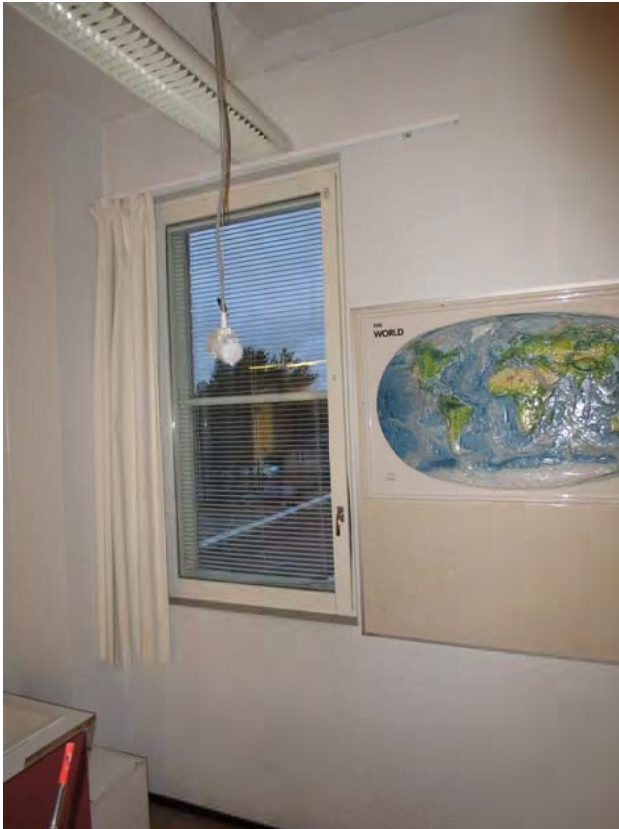
Kuvat 70 ja 71: Vuotoilmavirtauksia ikkunan karmin ja puitteen välistä (24)
