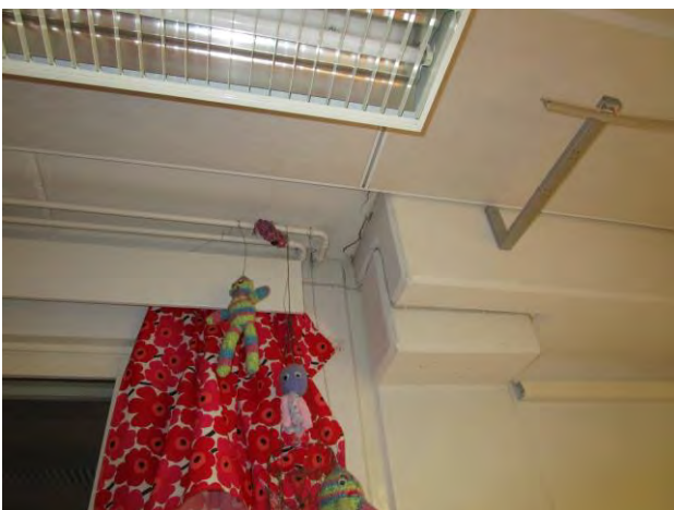
Kuvat 34 ja 35: Vuotoilmavirtauksia välipohjaan tehdystä putkiläpiviennistä (12)
