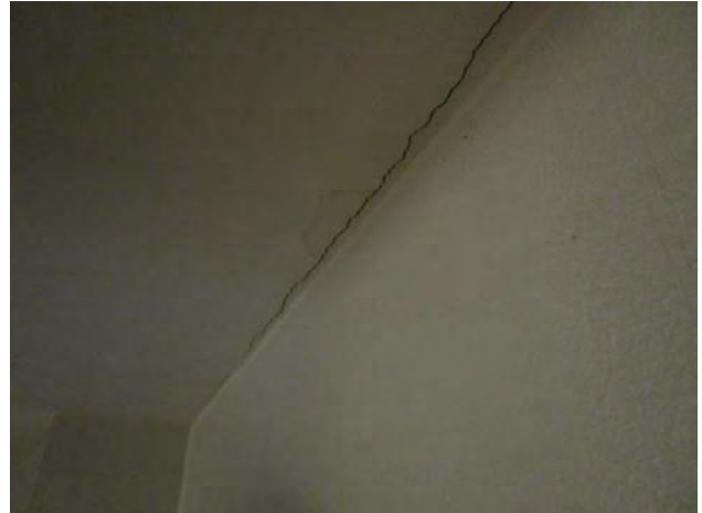
Kuvat 72-75: Vuotoilmavirtauksia ulkoseinän ja välipohjan liitoksessa olevasta halkeamasta (25)
