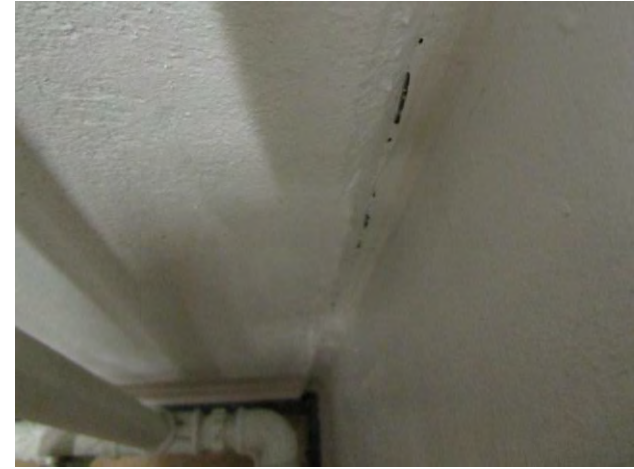
Kuvat 1-4: Vuotoilmavirtauksia betonipilarin ja seinärakenteen välisessä saumauksessa olevista halkeamista (1)
