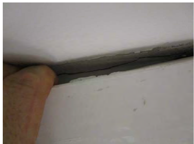
Kuvat 125-128: Vuotoilmavirtauksia väliseinän ja yläpohjan liitoksessa olevasta halkeamasta (46)
