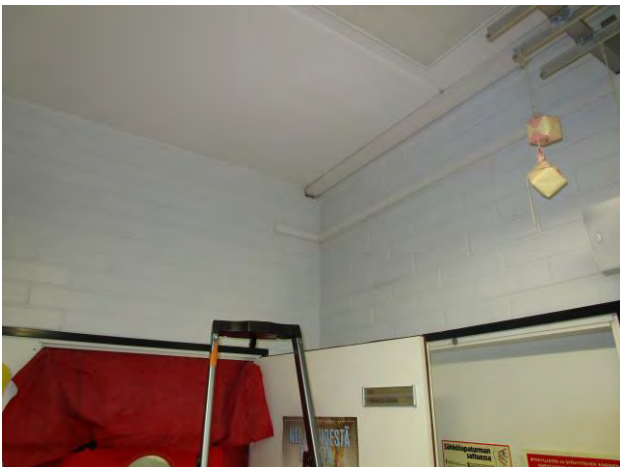
Kuvat 18 ja 19: Vuotoilmavirtauksia väliseinään kaapeleille tehdystä läpiviennistä (6)
