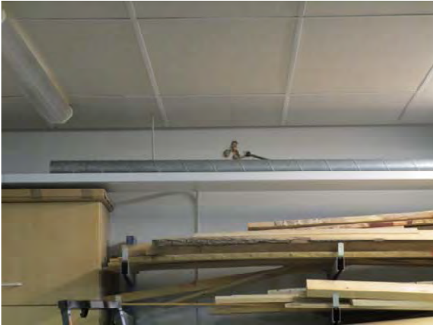
Kuvat 233 ja 234: Vuotoilmavirtauksia ulkoseinässä olevasta kaapeliläpiviennistä (84)
