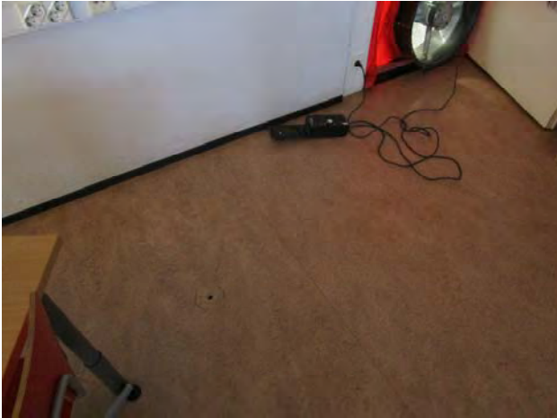
Kuvat 148 ja 149: Vuotoilmavirtauksia välipohjan rakenteesta käytöstä poistetusta läpivientiputkesta (54)
