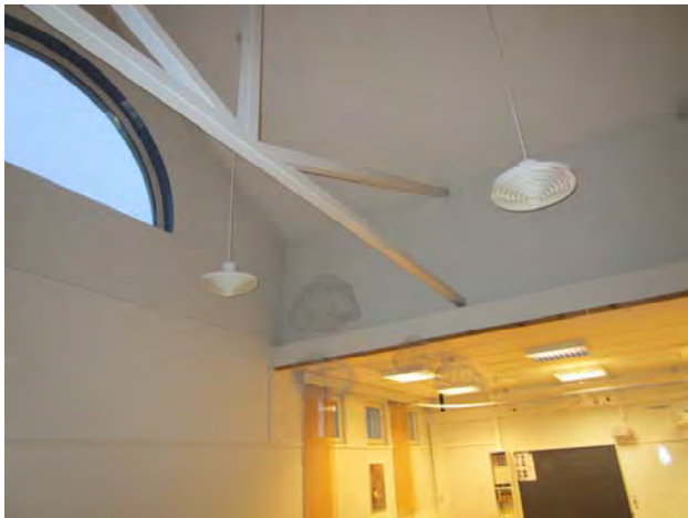
Kuvat 101 ja 102: Vuotoilmavirtauksia kattolyhdyn seinien ulkonurkassa (36)
