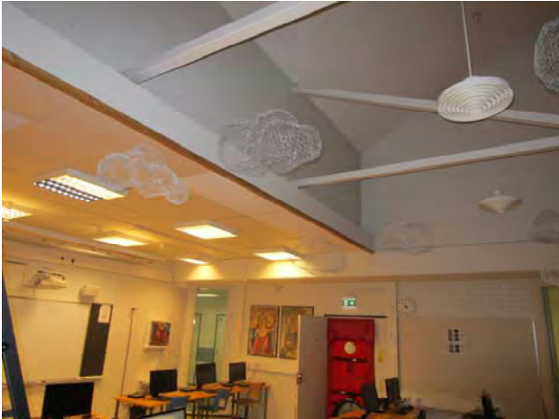
Kuvat 112 ja 113: Vuotoilmavirtauksia yläpohjan ja kattolyhdyn seinän liitoksesta (41)
