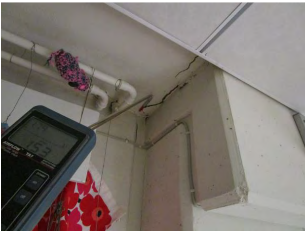
Kuvat 30-33: Vuotoilmavirtauksia betonirakenteiden liitoksissa olevista halkeamista (11)
