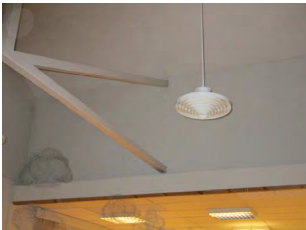
Kuvat 103 ja 104: Vuotoilmavirtauksia lyhdyn pintarakenteisiin teräsrakenteille tehdystä läpiviennistä (37)
