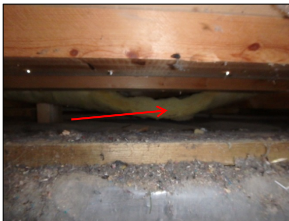
Kuva 22. Liikuntasalin lattiarakenne. Rakenteen eristeenä on villaeriste.
