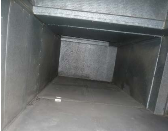
Kuva 179. IV-kone 303, raitisilmakanavassa risuja ja roskaa
