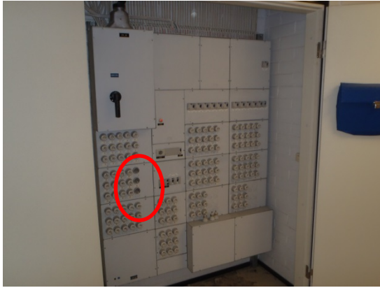
Kuva 233. Varokekansien pois paikaltaan, RK16.
