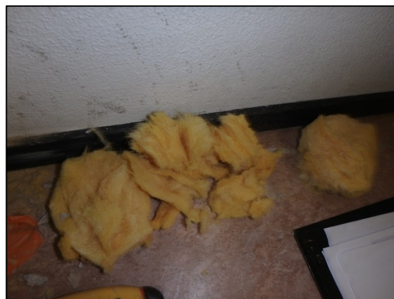
Kuva 57. Lämmöneristeenä on käytetty lasivillaa.
