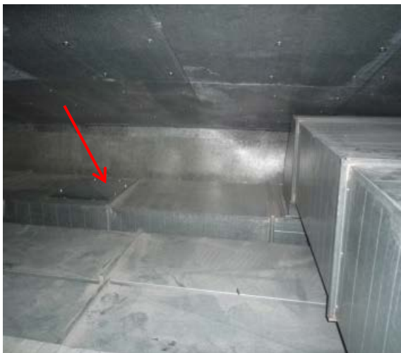
Kuva 149. IV-kone 301, raitisilmakanavan puhdistettavuus ennen tutkimuksia oli huono. Tutkimusten aikana kanavaan lisättiin puhdistusluukkuja
