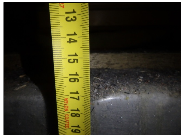
Kuva 23. Betonilaatan yläpinnassa on muovikalvo.
