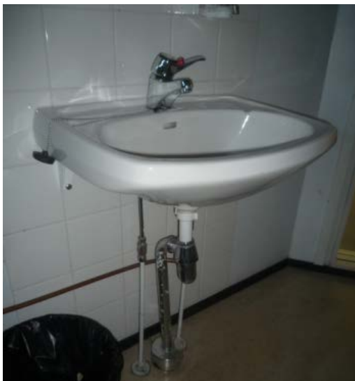
Kuva 227. Alkuperäinen pesuallas ja sekoittaja
