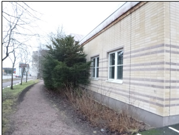
Kuva 29. Istutukset on toteutettu lähelle ulkoseinä rakennetta.
