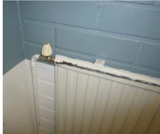
Kuva 224. Käsisäätöpyörällä varustettu patteri
