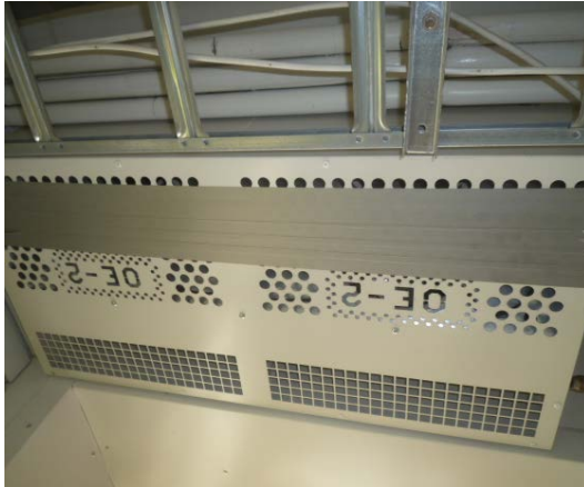
Kuva 223. Lämmitysverkoston kytketty oviverhokojen keittiön ulko-ovella
