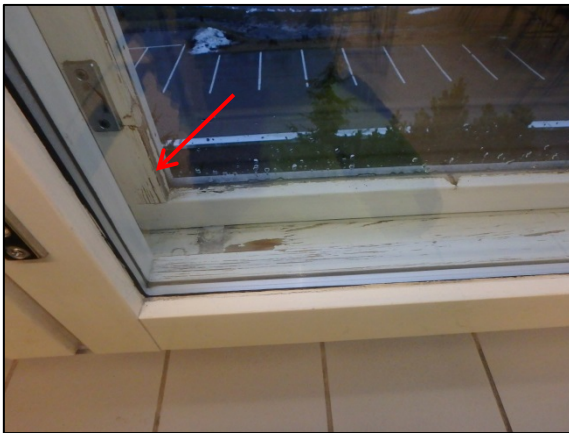
Kuva 37. Pinnoitevaurioita havaittiin myös ulkopuitteen sisäpuolisissa puuosissa.
