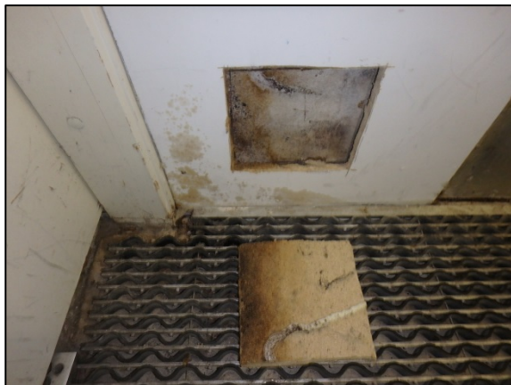
Kuva 58. Rakenneavaus toteutettiin tuulikaapin ulkoseinärakenteeseen.
