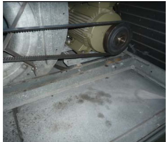
Kuva 158. Tutkimusten aikana tulopuhallinkammio puhdistettiin
