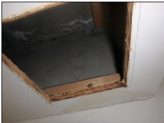
Kuva 85. Tilan 107 rakenneavaus ulkoseinän vierellä.
