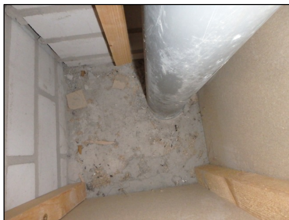
Kuva 105. Koteloinnin sisäpuolisissa osissa ei ole havaittavissa vaurioitumista.
