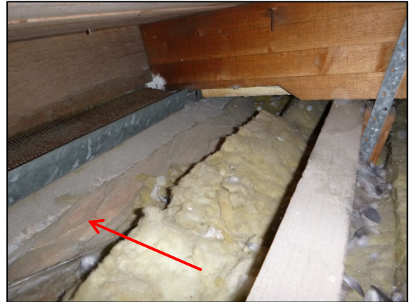
Kuva 124. Yläpohjatilan tuuletus on toteutettu räystääiden reikäpeltien avulla. Ulkoseinäelementtien yläpäässä on osittain paikoillaan rakennusaikaisena sääsuojauna käytetyt muovikalvot.
