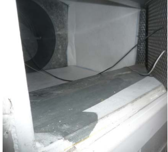
Kuva 213. Luokka 202, tuloilmapäätelaite, pölynkoostumusnäytteen ottopaikka (päätelaitteen vaimennusmateriaalit korvattu polyesteripohjaisella materiaalilla)
