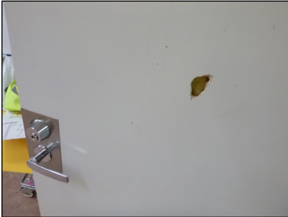
Kuva 81. Tilan 312 oven sisäpuoliset mineraalivillat ovat näkyvissä.
