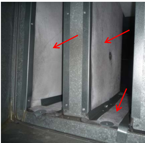
Kuva 177. Äänenvaimenninosan mineraalivilla peitetty polyesteripohjaisella materiaalilla
