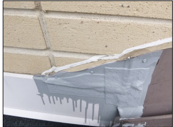
Kuva 136. Liikuntasalin katteen liitoskohtia on tiivistetty,
