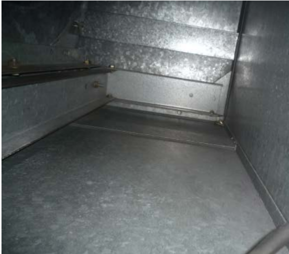
Kuva 200. IV-kone 304, tulopuhallinkammio on puhdistettu tutkimusten aikana
