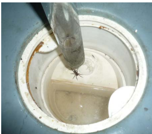
Kuva 229. Alkuperäinen muovinen lattiakaivo.
