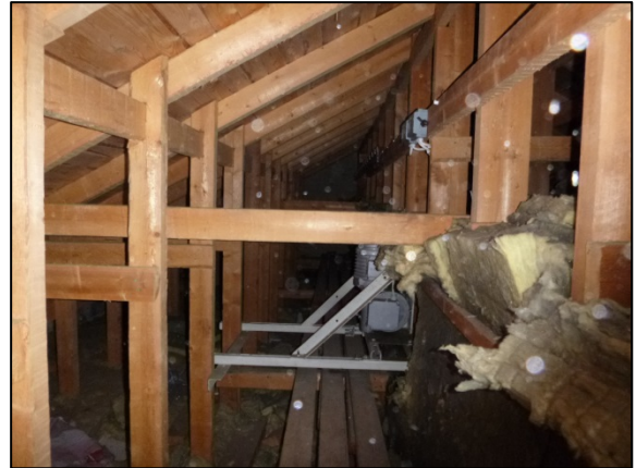
Kuva 128. Yleiskuva liikuntasalin harjakatto-osan yläpohjajälästä.
