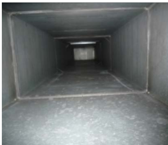
Kuva 144. Tutkimusten aikana IV-koneen 301 raitisilmakanava puhdistettiin perusteellisesti. Kanava on puhdas.
