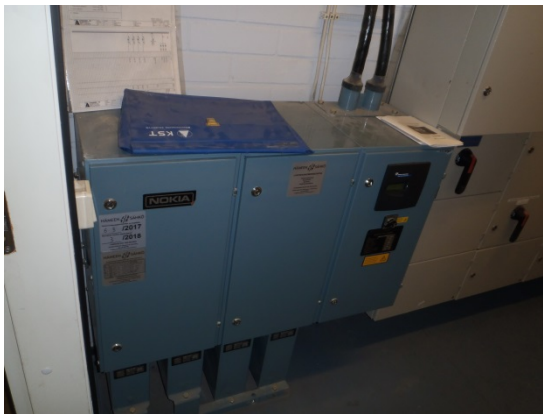
Kuva 235. Alkuperäinen kompensointilaitteisto.
