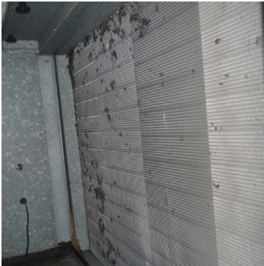
Kuva 173. IV-kone 302, tutkimusten alussa lämmityspatteri oli likainen
