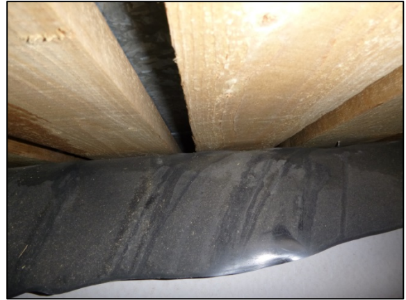
Kuva 122. Muovikalvo asennettu ruodelaudoituksen alapuolelle edellisen kuvan kohdalla.
