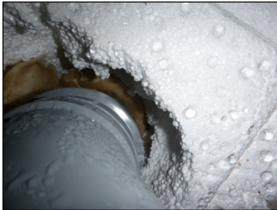
Kuva 15. Lämpivientien ympärille on asennettu mineraalivillaa-eristeet.
