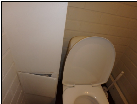
Kuva 106. Hormikoteloinnissa on viemäriputki.
