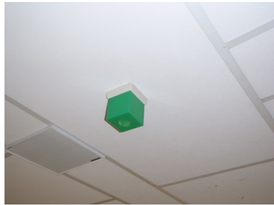
Kuva 243. Poistumisopaste ja -valaisin.
