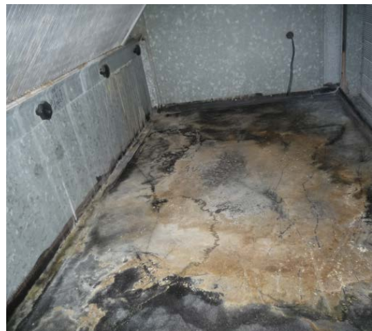
Kuva 172. IV-kone 302, LTO:n jälkeinen kammion pohja lämmityspatterin edessä on puhdistettu tutkimusten aikana (pinttynneen rasvalian jättämien jälkien täydellinen poistaminen hankalaa)
