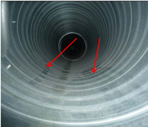
Kuva 206. Koneen 301 palvelualue, likainen tuloilmakanava, pölynkoostumusnäyteen nro 1 ottopaikka kotitalousluokassa 158 (kanavaan tehdyt pyyhkäisyjäljet osoitettu kuvassa)
