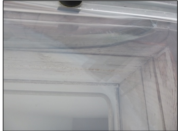
Kuva 134. Kattoikkunan sisäpuolissa osissa on kosteuden aiheuttamia jälkiä.
