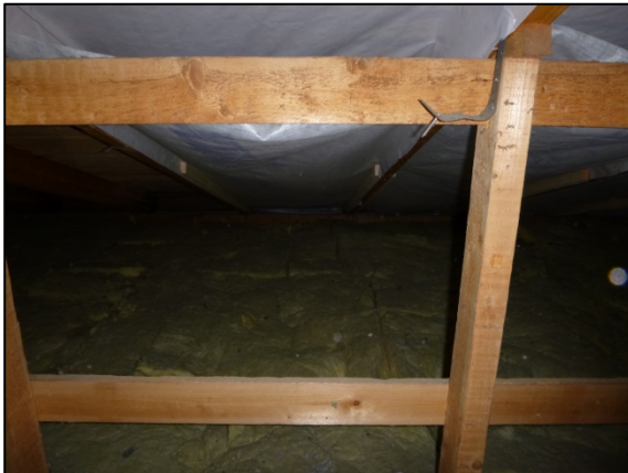
Kuva 125. Tilojen 341 ja 342.2 yläpuolelle asennettiin tutkimushetkellä aluskatetta puurakenteiden väliin.
