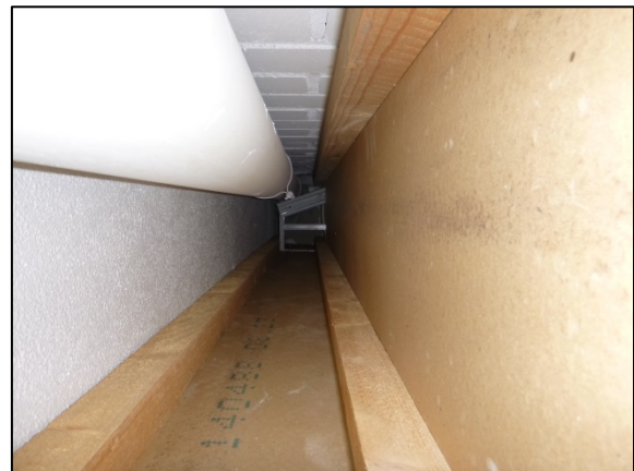
Kuva 93. Koteloinnin sisäpuolisissa osissa ei havaittu vaurioitumista.
