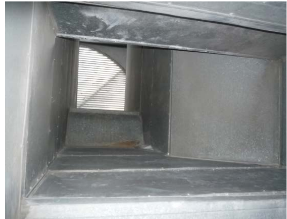
Kuva 189. IV-koneen 304 raitisilmakanava puhdistuksen jälkeen. Kanava on puhdas.
