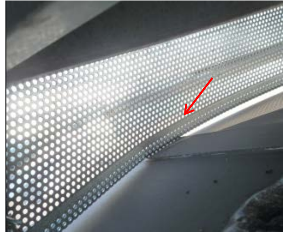
Kuva 141. Tutkimusten aikana raitisilmanottokatosten alaosaan lisättiin suojaverkko
