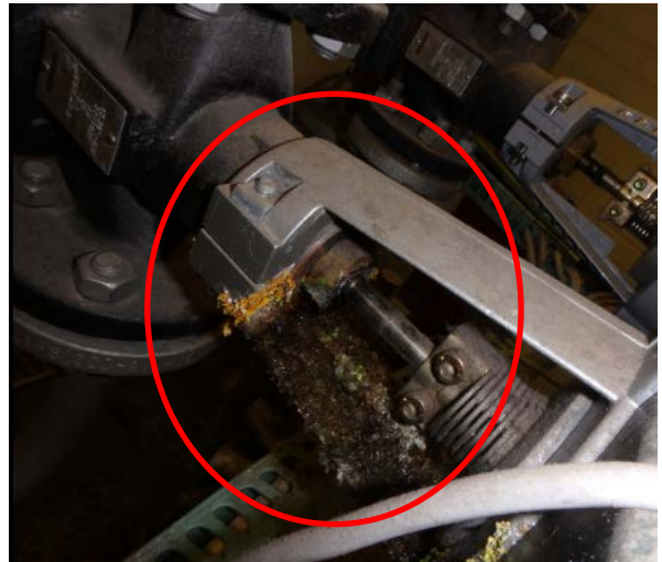
Kuva 219. Vuotava moottoriventtiili
