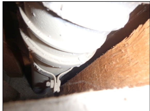
Kuva 101. Koteloinnin sisäpuolisissa osissa ei havaittu vaurioitumista.
