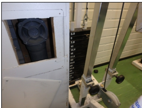
Kuva 104. Hormikoteloinnissa on viemäriputki.
