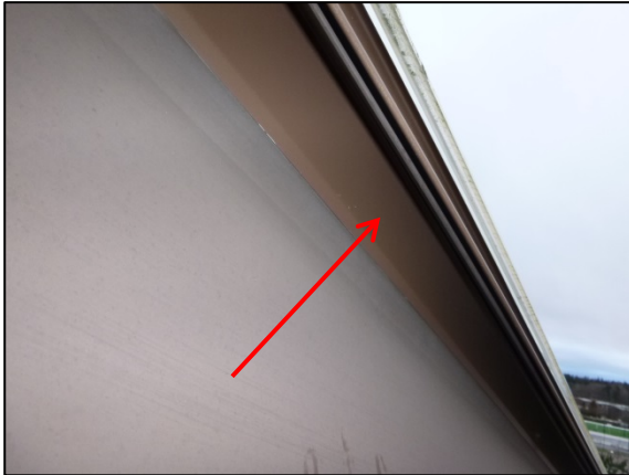
Kuva 133. Porrashuoneen valokuilun pelttilistä aiheutti tutkimushetkellä jatkuvaa räminää sisätiloihin tuulella.
