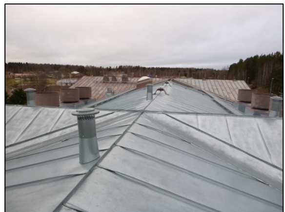
Kuva 132. Vesikatetta on osin uusittu rakennuksen keskiosilla.
