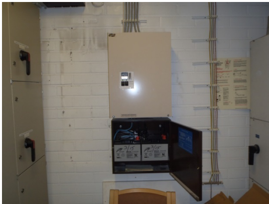
Kuva 242. Turvavalo-keskus sähköpääkeskustilassa.
