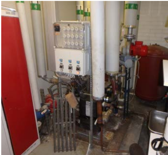
Kuva 218. Kaukolämmön alajakokeskus
