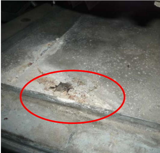
Kuva 169. IV-kone 302, tutkimusten alussa tulo-suodatinkammio oli likainen (kammio puhdistettu tutkimusten aikana).
