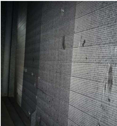
Kuva 196. IV-kone 304, ensimmäisessä tarkastuksessa lämmityspatterissa oli havaittavissa likaantumista
