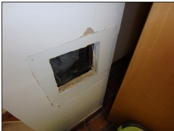
Kuva 102. Hormikoteloinnissa on viemäriputki.
