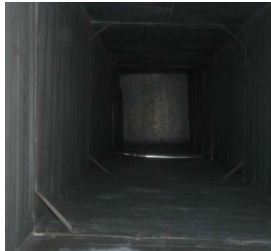
Kuva 164. Tutkimusten aikana IV-koneen 302 raitisilmakanava puhdistettiin perusteellisesti. Kanava on puhdas.
