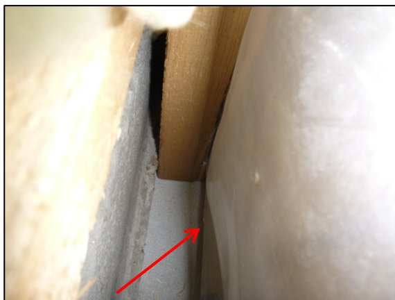
Kuva 50. RA 5, Muovikalvo on avoin alareunasta, vasemmalla yläpohjan ontelolaatta.
