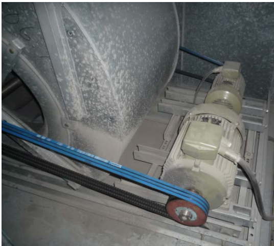
Kuva 187. Poistoilmapuhallinkammio on pölyinen
