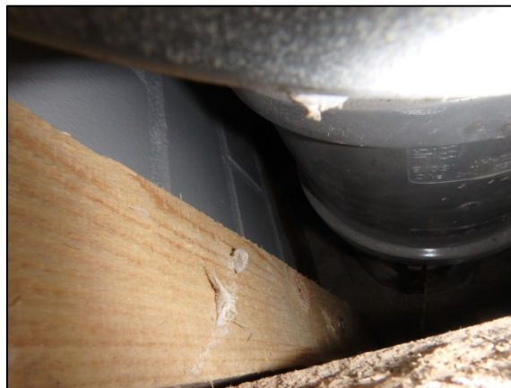
Kuva 107. Koteloinnin sisäpuolisissa osissa ei ole havaittavissa vaurioitumista.
