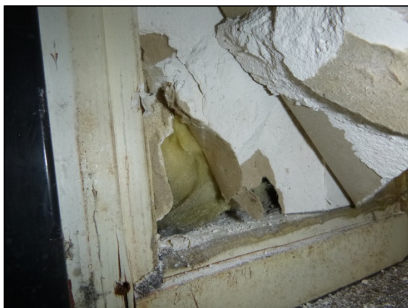
Kuva 98. Koteloinnin sisäpuolisissa osissa ei havaittu aistinvaraisesti vaurioitumista.
