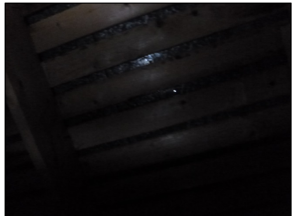
Kuva 120. Yksittäinen reikä vesikatossa noin tilan 315.3 yläpuolella
