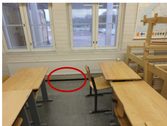
Kuva 18. Koira ilmaisi lattian ja seinän rajan.
