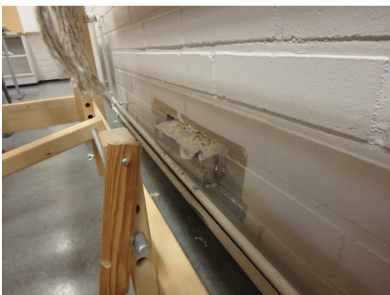
Kuva 17. Koira ilmaisi ulkoseinän kohtaan, jossa oli irrotettu tiili.
