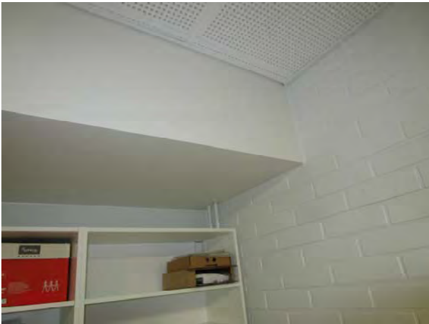
Kuvat 73 ja 74: Vuotoilmavirtauksia kotelarakenteesta putkille verhoukslevyyn tehdyistä läpivienneistä (27)
