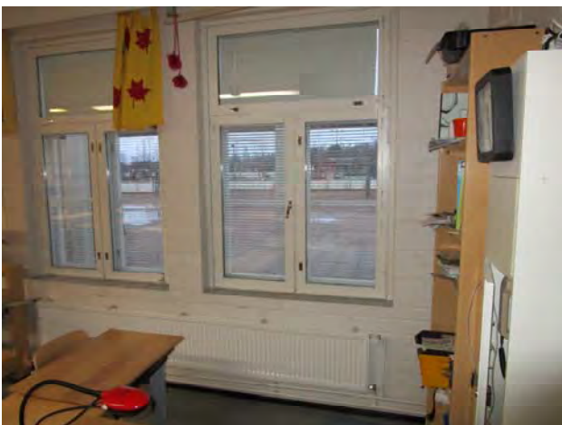
Kuvat 202 ja 203: Vuotoilmavirtauksia ikkunan karmin ja puitteiden välistä sekä ikkunan seinäliittymistä (76)
