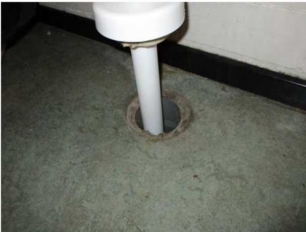
Kuvat 45-48: Vuotoilmavirtauksia pesualtaan viemäristä. Mansetti ei tiivistä kunnolla viemäriputkeen. (19)
