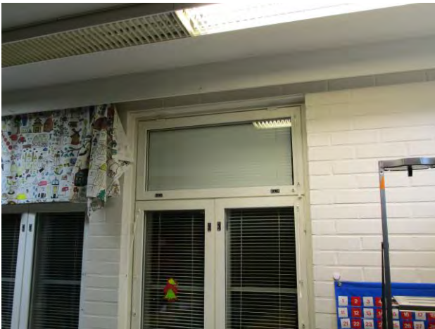
Kuvat 16 ja 17: Vuotoilmavirtauksia ikkunan karmin ja puitteen välistä sekä ikkunan seinäliittymistä (7)
