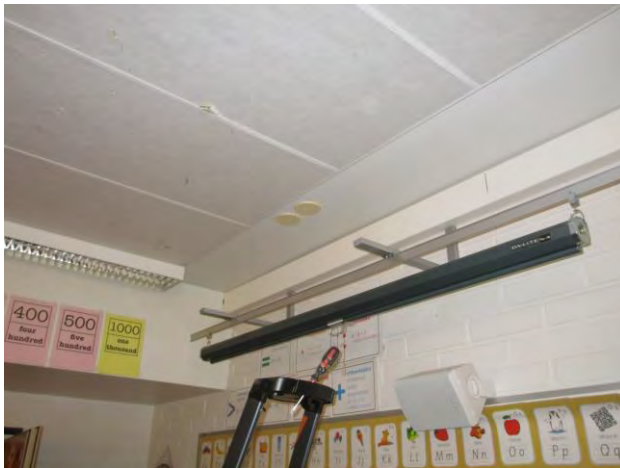
Kuvat 33 ja 34: Vuotoilmavirtauksia yläpohjassa olevista jakorasioista (14)
