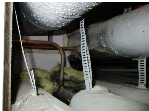
Kuvat 39-42: Vuotoilmavirtauksia lämmönjakohuoneen vastaiseen seinään tekniikalle tehdyistä ja puutteellisesti tiivistetyistä läpiviennistä (17)
