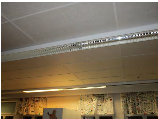
Kuvat 43 ja 44: Vuotoilmavirtauksia yläpohjarakenteeseen valaisimen kaapelille tehdystä läpiviennistä (18)
