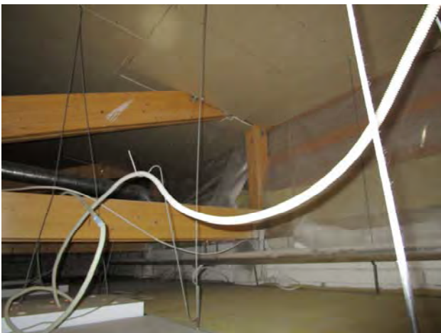
Kuvat 267-274: Vuotoilmavirtauksia alaslasketun kattoverhouksen yläpuolella. Akustiikkalevyn yläpuolella todettiin puutteita höyrinsulkumuovin asennuksessa. (101)
