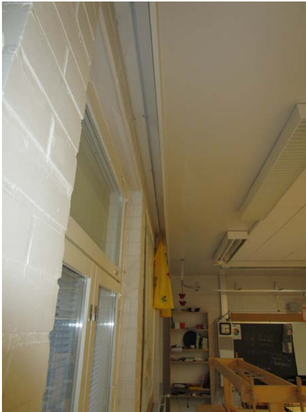
Kuvat 204 ja 205: Vuotoilmavirtauksia ulkoseinän ja yläpohjan liitoksesta verholautarakenteen takaa (77)
