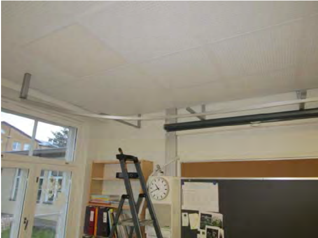
Kuvat 85 ja 86: Vuotoilmavirtauksia yläpohjarakenteeseen kaapeleille tehdystä läpiviennistä (33)
