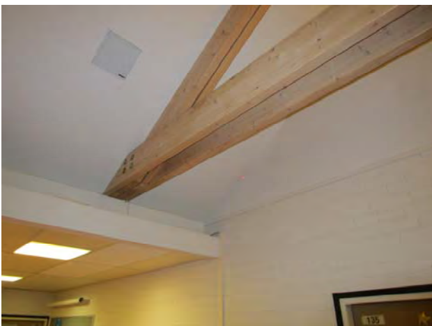
Kuvat 247 ja 248: Vuotoilmavirtauksia yläpohjarakenteen ja kantavan puupalkin liitoksesta (94)
