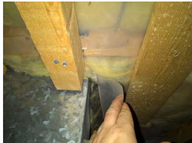
Kuvat 122-126: Avatun kattolevyn kautta todettiin suuria vuotoilmavirtauksia yläpohjan höyrynsulkumuoviin IV-kanavalle tehdystä läpiviennistä. Höyrynsulkumuovi ei ole lainkaan liitetty IV-kanavaan. (45)
