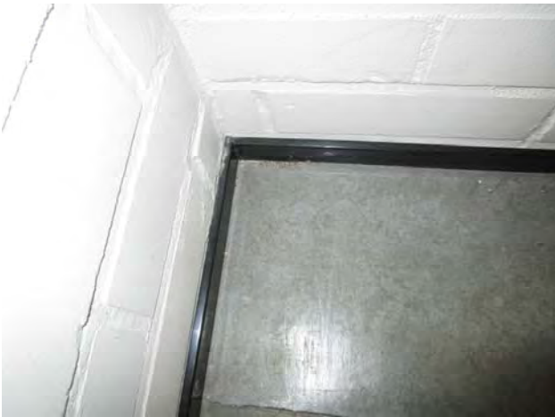
Kuvat 219 ja 220: Pieniä vuotoilmavirtauksia ulkoseinän ja alapohjan liitoksesta (83)
