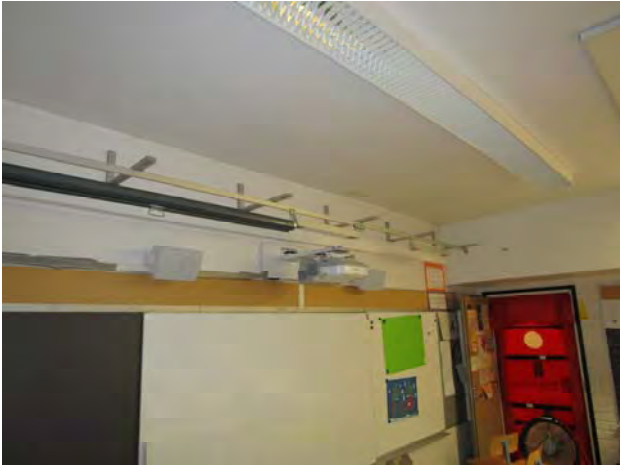
Kuvat 185 ja 186: Vuotoilmavirtauksia väliseinän ja yläpohjan liitoksesta (69)
