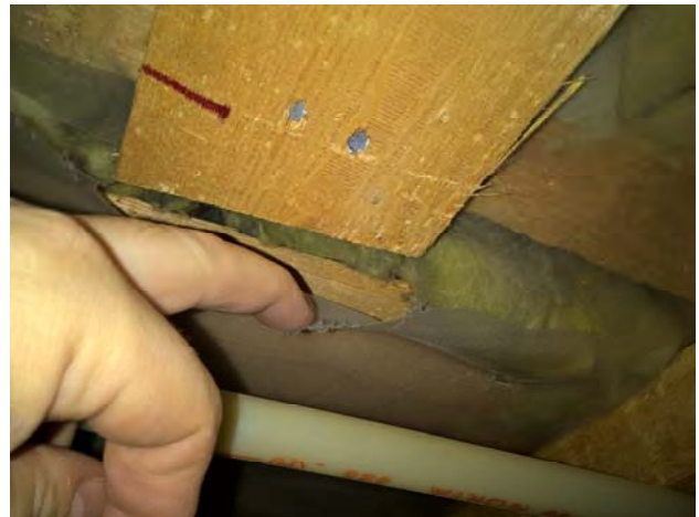
Kuvat 117-121: Avatun kattolevyn kautta todettiin puutteita yläpohjan höyrinsulkumuovin asennuksessa (44)
