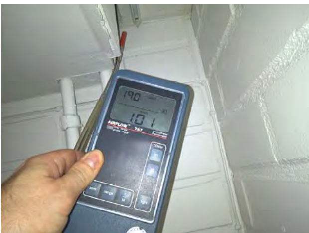
Kuvat 87-89: Vuotoilmavirtauksia kotelorakenteesta (34)
