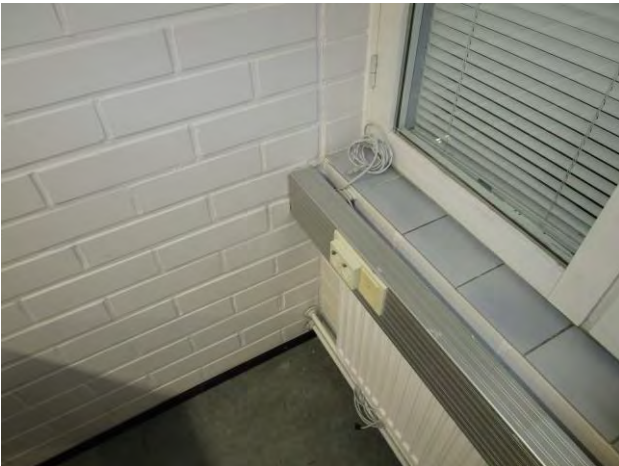
Kuvat 58 ja 59: Vuotoilmavirtauksia väliseinään lämpöputkille tehdyistä läpivienneistä (23)
