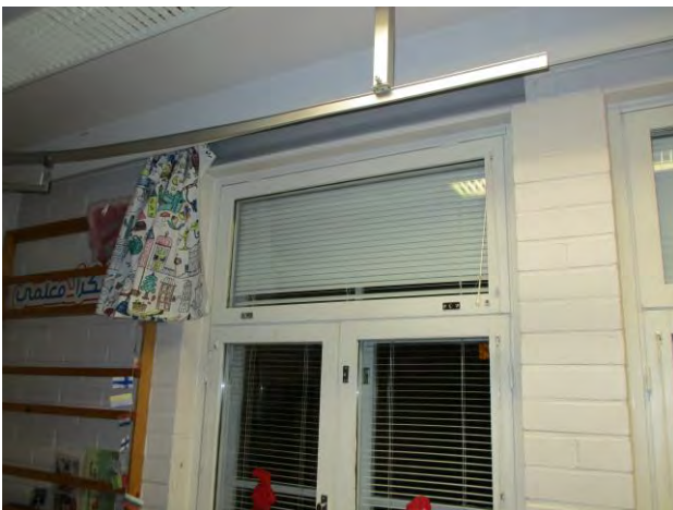
Kuvat 25 ja 26: Vuotoilmavirtauksia ikkunan karmin ja puitteiden välistä sekä ikkunan seinäliittymästä (11)
