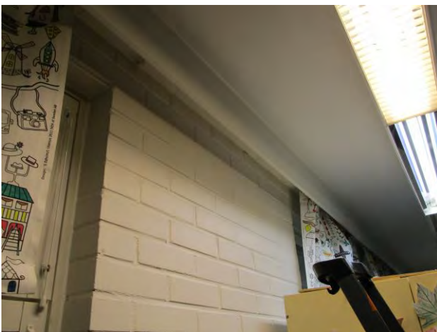
Kuvat 14 ja 15: Vuotoilmavirtauksia ulkoseinän tiilimuurauksen ja yläpohjan välisestä liitoksesta verholautarakenteen takaa (6)
