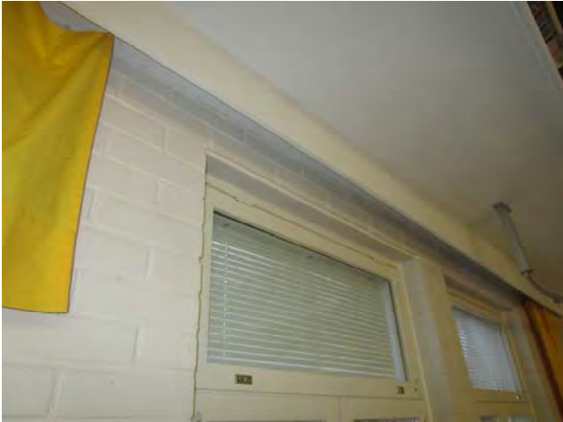
Kuvat 173 ja 174: Vuotoilmavirtauksia ulkoseinän ja yläpohjan liitoksesta verholautarakenteen takaa (64)
