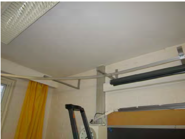
Kuvat 187 ja 188: Vuotoilmavirtauksia yläpohjaverhoukseen kaapeleille tehdystä ja puutteellisesti tiivistetystä läpiviennistä (70)
