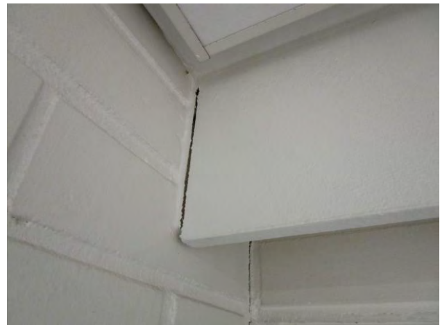
Kuvat 51-54: Vuotoilmavirtauksia ulkoseinän ja yläpohjan liitoksesta verholautarakenteen takaa (21)
