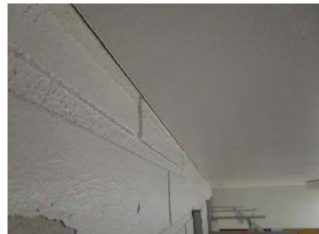
Kuvat 181-184: Vuotoilmavirtauksia väliseinän ja yläpohjaverhouksen välisestä raosta (68)
