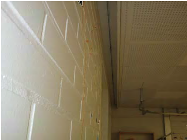
Kuvat 138 ja 139: Vuotoilmavirtauksia ulkoseinän ja yläpohjan liitoksesta verholautarakenteen takaa (50)
