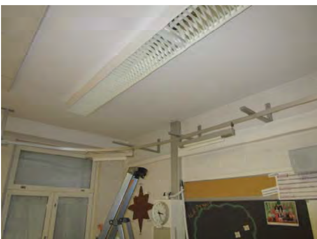
Kuvat 211 ja 212: Vuotoilmavirtauksia kaapelikotelon ja yläpohjaverhouksen liitoksesta (80)
