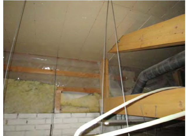
Kuvat 263-266: Vuotoilmavirtauksia alaslasketun kattoverhouksen yläpuolella. Akustiikkalevyn yläpuolella todettiin puutteita höyrynsulkumuovin asennuksessa. (100)
