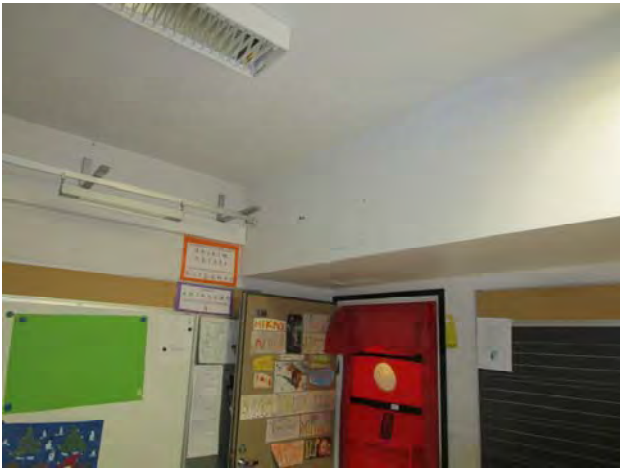
Kuvat 149 ja 150: Vuotoilmavirtauksia kotelorakenteesta luukun reunojen kautta (55)
