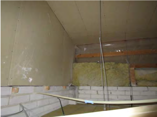
Kuvat 263-266: Vuotoilmavirtauksia alaslasketun kattoverhouksen yläpuolella. Akustiikkalevyn yläpuolella todettiin puutteita höyrynsulkumuovin asennuksessa. (100)
