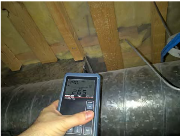
Kuvat 122-126: Avatun kattolevyn kautta todettiin suuria vuotoilmavirtauksia yläpohjan höyrynsulkumuoviin IV-kanavalle tehdystä läpiviennistä. Höyrynsulkumuovi ei ole lainkaan liitetty IV-kanavaan. (45)
