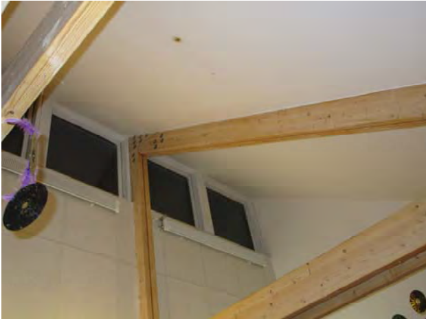
Kuvat 254 ja 255: Vuotoilmavirtauksia yläikkunoiden liitoksista seinä-/yläpohjarakenteeseen (97)
