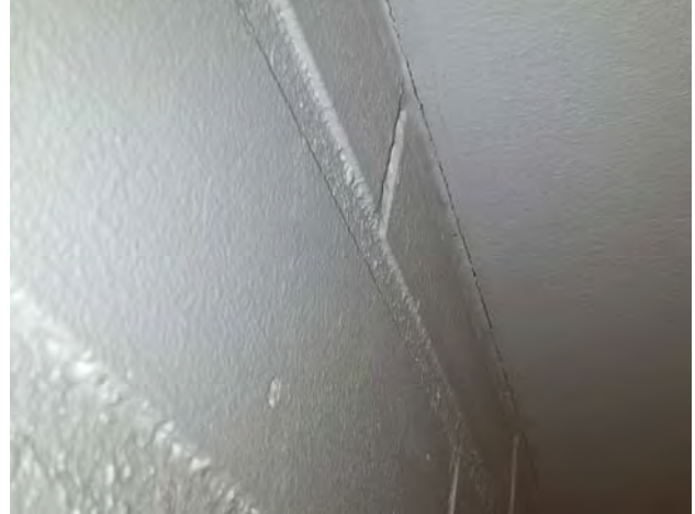
Kuvat 105-108: Vuotoilmavirtauksia kattoverhouksen ja väliseinän liitoksessa olevista halkeamista (41)
