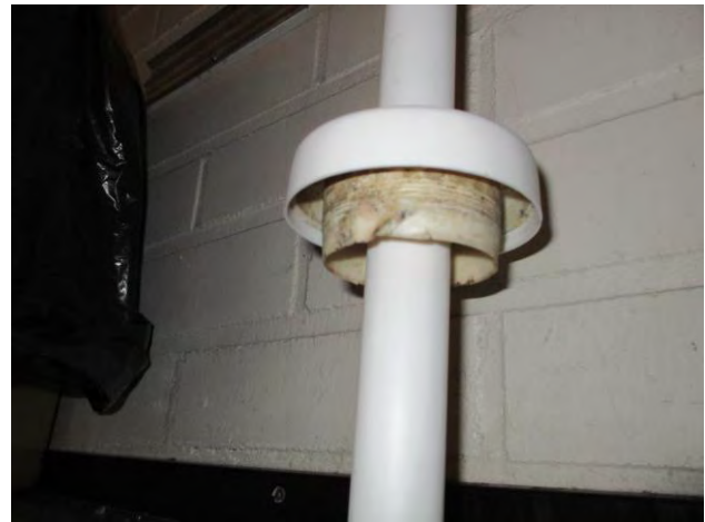
Kuvat 45-48: Vuotoilmavirtauksia pesualtaan viemäristä. Mansetti ei tiivistä kunnolla viemäriputkeen. (19)
