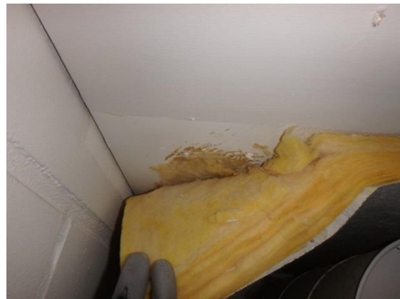
Kuva 4. Akustolevyjen liima-aineessa ei ole asbestia (näyte nro 3).
