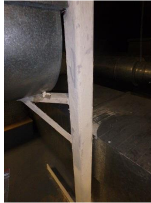
Kuva 8. Yläkoulu, iv-konehuoneen massaeriste ei sisällä asbestia.
