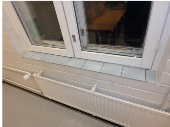
Kuva 10. Ylä- ja alakoulun ikkunapenkkinen laatoitukset eivät sisällä asbestia (näytteet nro 1 ja 17).
