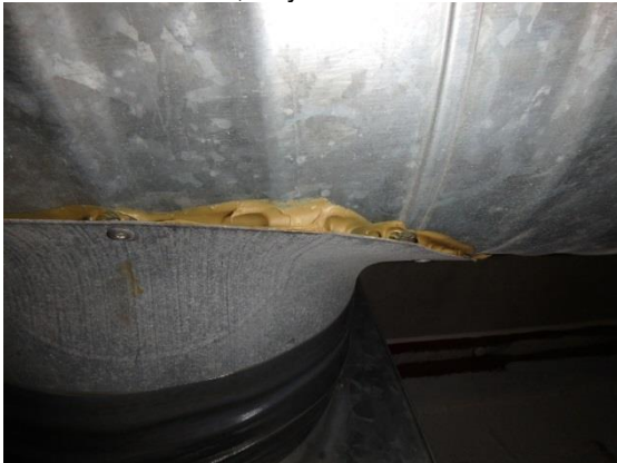
Kuva 9. Ilmanvaihtolaitteistojen kitti ei sisällä asbestia (näyte 12).
