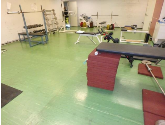
Kuva 7. Yläkoulu, voimailusalin vihreä matto ei sisällä asbestia, näyte15.
