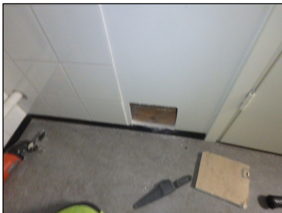
Kuva 77. Rakenneavauksen sijainti väliseinän alaosassa.
