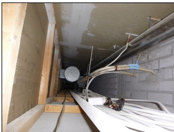
Kuva 81. Koteloinnin sisäpuolisissa osissa ei havaittu vaurioitumista.
