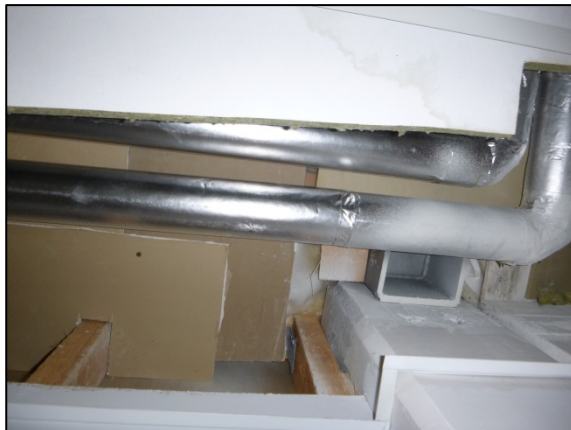
Kuva 125. Rakenneavaus 13 betonipilarin vierellä
