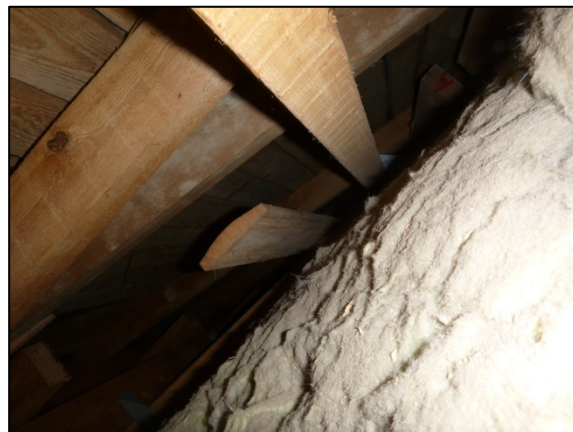
Kuva 115. Rakenneavauskohdalla olevaa yläpohjatilaa.
