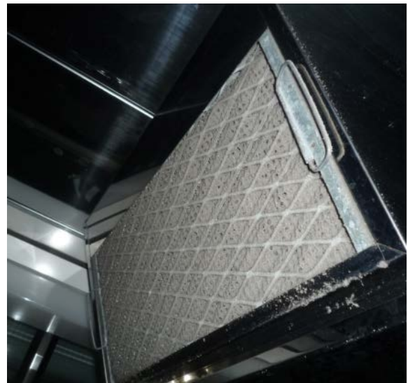
Kuva 167. Keittiön huuvarn asvasuodattimessa on runsasta pölykertymää
