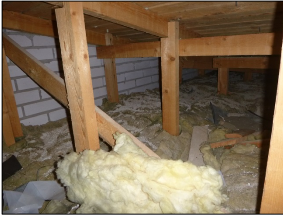
Kuva 86. Yleiskuva avoimesta yläpohjatilasta.
