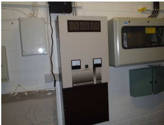
Kuva 200. Turvavalo-keskus sähköpääkeskustilassa.
