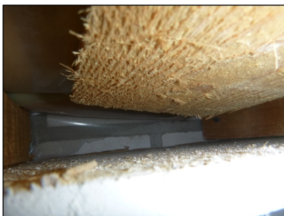
Kuva 121. Yläpohjan rakenteissa ei havaittu aistinvaraisesti vaurioitumista.
