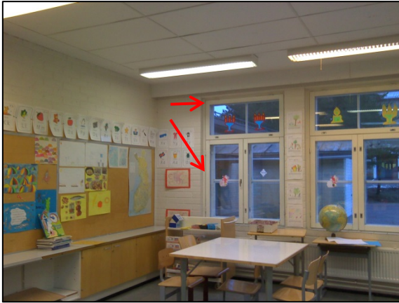
Kuva 44. Vähäisiä ilmavuotoja puitteen ja karmien välistä (kts. viereinen kuva).
