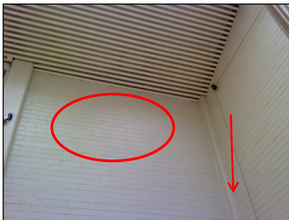
Kuva 36. Lämpökamerakuvassa näkyviä kylmempiä alueita (kts. viereinen kuva).
