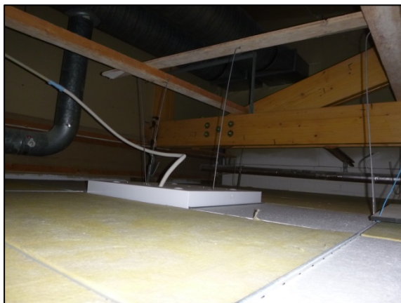
Kuva 68. Alaslaskettujen kattojen akustiikkalevyt ovat osin pinnoittamattomia villalevyjä.
