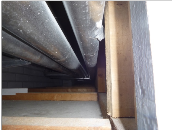
Kuva 83. Koteloinnin sisäpuolisissa osissa ei havaittu vaurioitumista.
