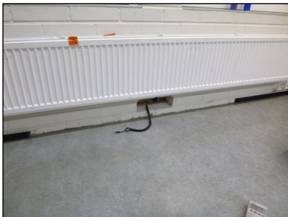
Kuva 56. Rakenneavauksen 6 sijainti seinän alaosassa.
