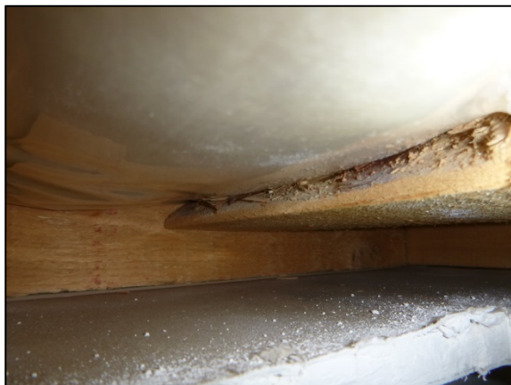
Kuva 114. Muovikalvon alapuolissa rakenteissa ei havaittu aistinvaraisesti vaurioita.
