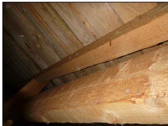
Kuva 118. Vesikaton rakenteissa ei havaittu vaurioitumista.
