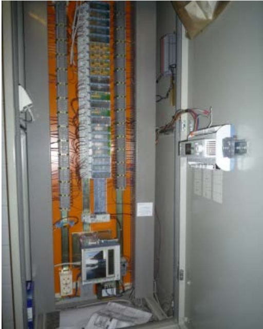
Kuva 207. Valvonta-alakeskus lämmönjakohuoneessa
