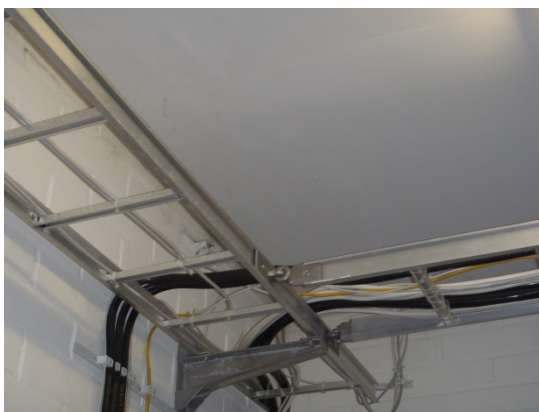
Kuva 185. Kaapelihyllyjä sähköpääkeskustilassa.
