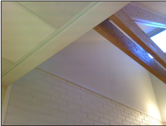
Kuva 47. Rakenneavauksen sijainti ulkoseinärakenteessa.
