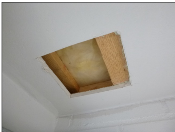
Kuva 117. Rakenteissa ei havaittu aistinvaraisesti vaurioitumista.
