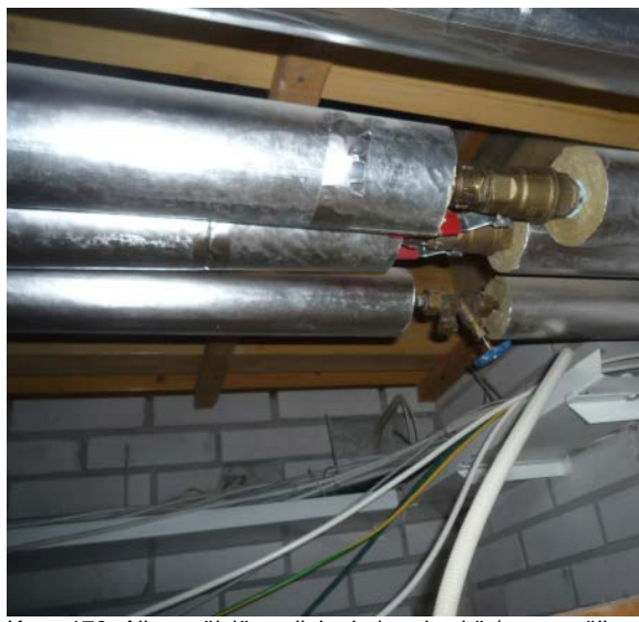
Kuva 178. Alkuperäisiä vesijohtoja ja eristeitä (opetusvälinetilan 119 alakatto)
