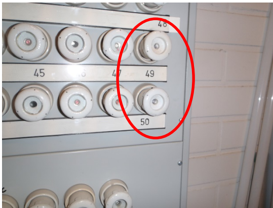
Kuva 189. Varokekansien lasia puuttuu, RK15.
