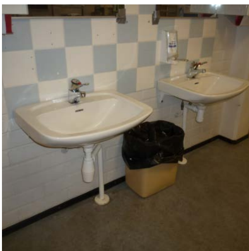
Kuva 179. Alkuperäisiä vesikalusteita ruokalassa
