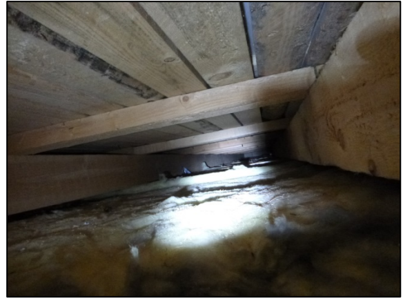
Kuva 87. Yleiskuva, vesikatteen suuntaisesti eristetty yläpohja.
