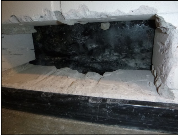
Kuva 52. Rakenneavaus 4. Bitumikermi on nostettu sisäpuolisen tiilimuurauksen ulkopintaan.
