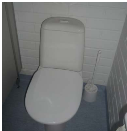
Kuva 180. Uusittu kaksoishuhtelulla varustettu WC-istuin.
