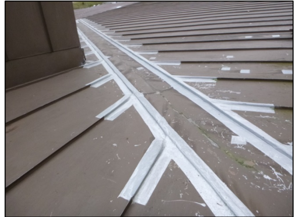
Kuva 105. Peltikatteen saumauksia on tiivistyskorjattu.
