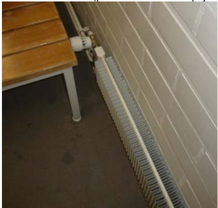
Kuva 173. Konvektorimallinen lämmityspatteri pukuhuoneessa 112. Venttiili ja termostaatti uusittu
