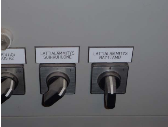
Kuva 199. Lattialämmitysten ohjauskytkimet.
