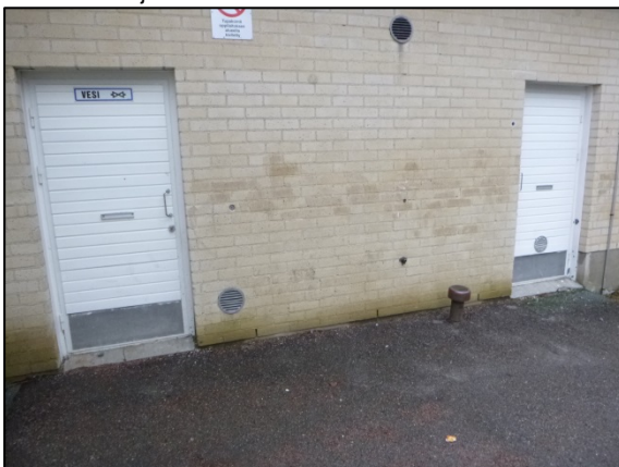
Kuva 26. Tiilimuuraus on lähellä maanpintaa ja muurauksen alaosa on kostea.
