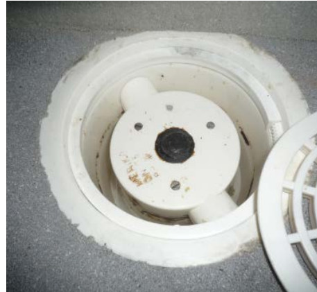
Kuva 184. Muovinen lattiakaivo suihkutilassa
