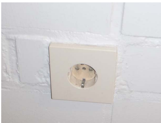
Kuva 192. Alkuperäinen uppoasennuspistorasia.
