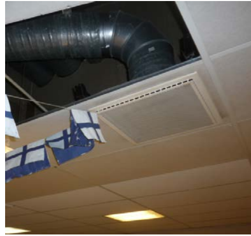
Kuva 165. Ruokalan tuloilmapäätelaite
