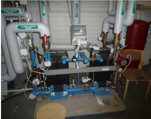
Kuva 168. Kaukolämmön alajakokeskus
