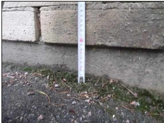
Kuva 6. Ulkopuolinen maanpinta on lähellä ulkoseinärakennetta.
