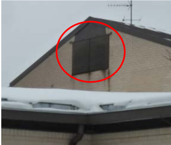
Kuva 129. Raitisilmasäleikkö päätyseinällä
