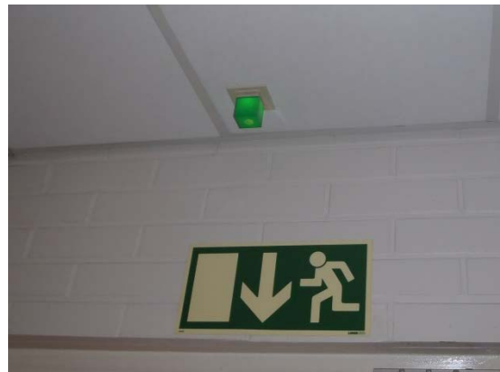
Kuva 201. Poistumisopaste ja -valaisin.
