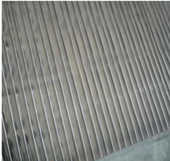
Kuva 141. LTO-kuutiossa havaittavissa pölyntymistä poistoilmapuolella
