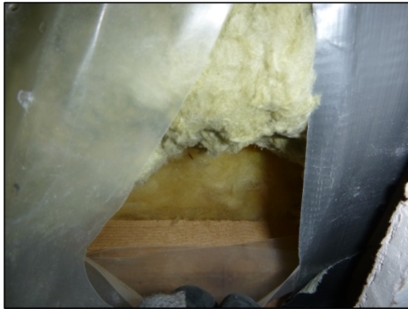
Kuva 119. Yläpohjan muovikalvoa on teipattu ilmastointiteipillä ja yläpohjaan on asennettu 50 mm lisälämmöneristys.
