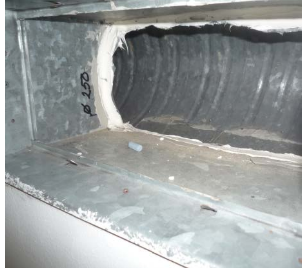
Kuva 163. Luokka 101, tuloilmasäleikön takana säleikön kiinnityslaatikon pohjalla on likaa
