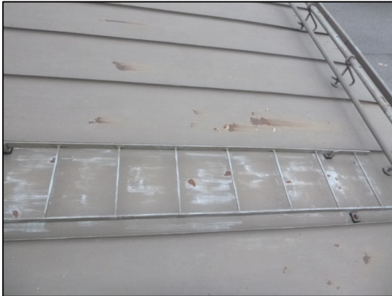
Kuva 108. Vesikaton kattovarusteet on kiinnitetty kattopellin lävitse puurunkorakenteisiin. Osa läpivientikohdista on osin auki ja osin tiivistetty silikonimassalla.
