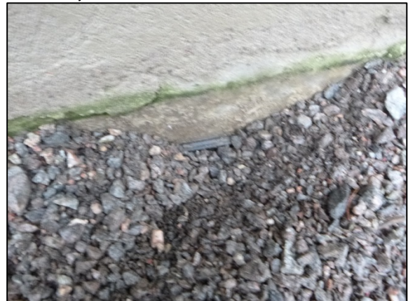
Kuva 7. Patolevyn yläreuna on noin 120 mm maanpinnan alapuolella.
