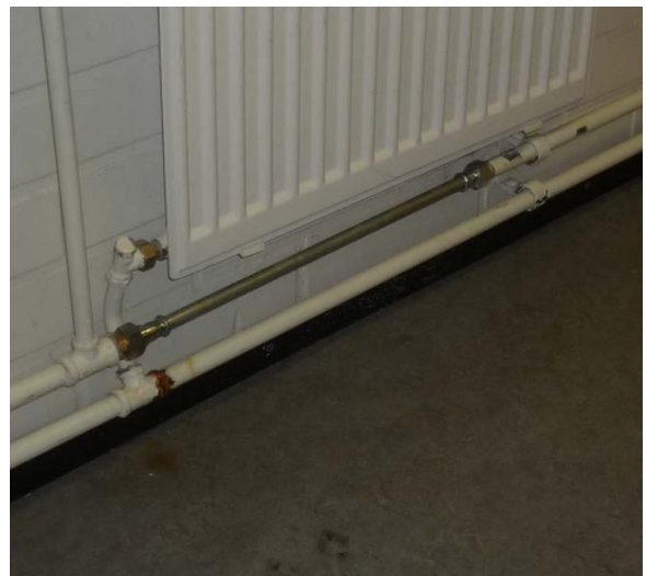
Kuva 170. Uusittu putkiosuus patterin alapuolella (tila 190)
