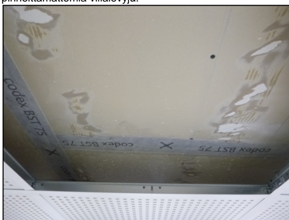
Kuva 70. Luokkatilan uutta alakattorakennetta, vanhaa kattorakennetta tiivistetty saumakohdista.
