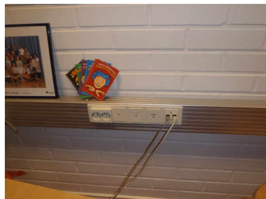
Kuva 186. Alkuperäisiä johdokouruasennuksia.
