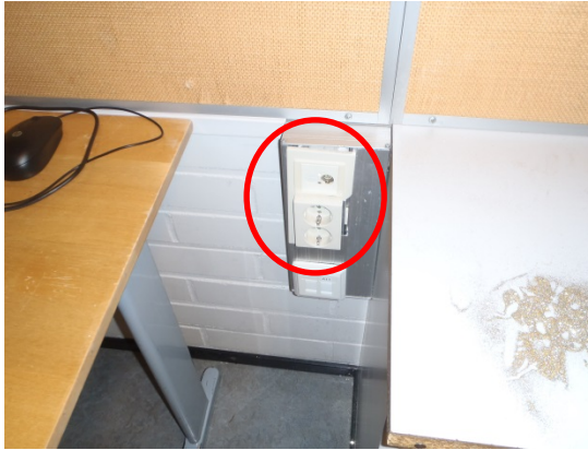
Kuva 194. Rikkinäinen pistorasian peitelevy, luokka 136.
