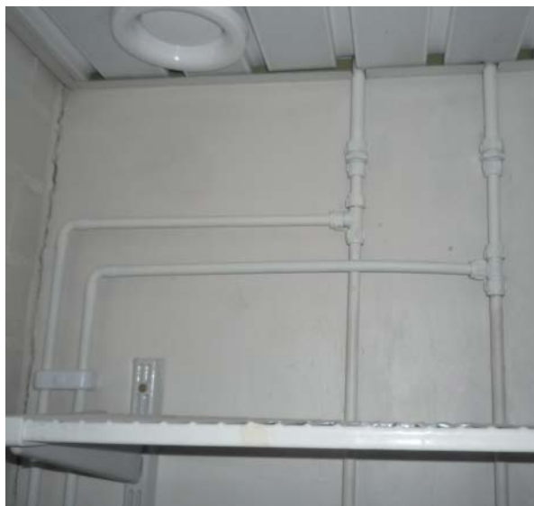
Kuva 177. Alkuperäisiä vesijohtoasennuksia. Liitokset toteutettu puserrusliitoksina ja juotosliitoksina
