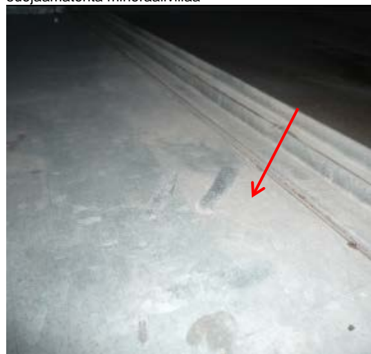
Kuva 140. Poistoilmasuodatinkammiossa lievää pölyyntymistä, pyyhkäisyjälki osoitettu kuvassa
