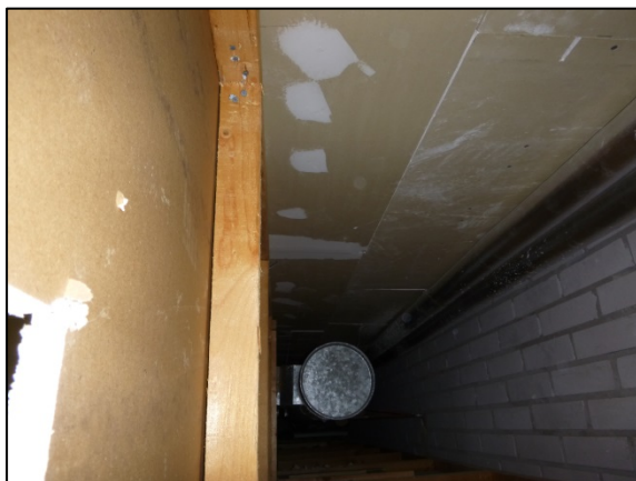
Kuva 79. Koteloinnin sisäpuolisissa osissa ei havaittu vaurioitumista.
