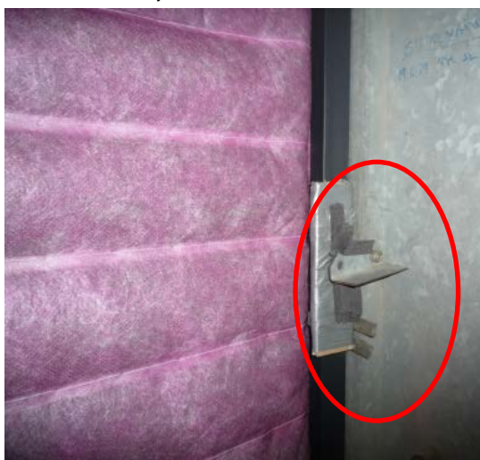
Kuva 145. TF2, tulosuodattimien kiristykseen käytetty pahvinpaloja
