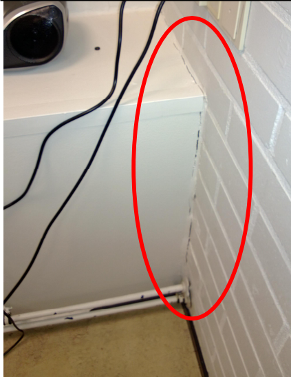
Tiivistemassan tartunta irronnut
