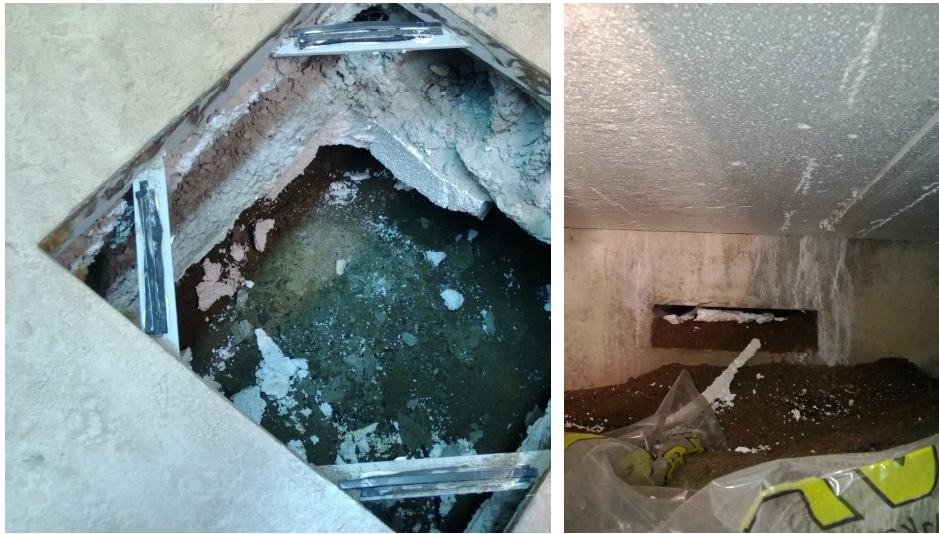
Kuvat 10–11. Ryömintätilan luukku ja näkymä ryömintätilaan.
