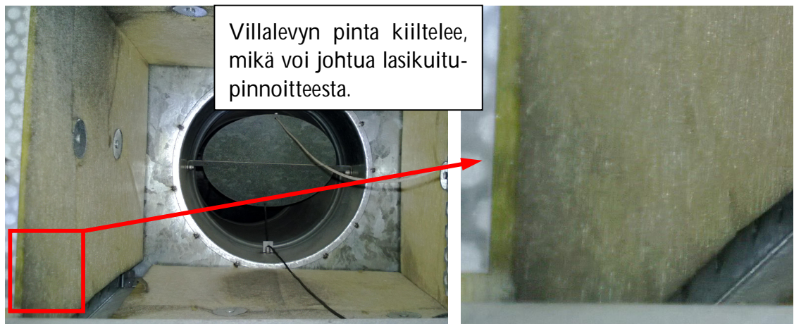
Kuvat 33–34. Tilan 303 tuloilman päätelaitteen äänenvaimennusvilla on todennäköisesti lasikuitupinnoitettu.
