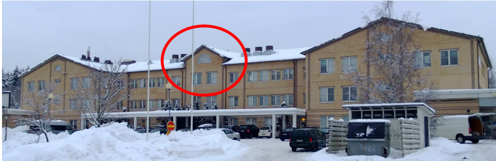
Kuva 23. Kattovuotoja on erityisesti todettu rakennuksen keskikohdalla.
