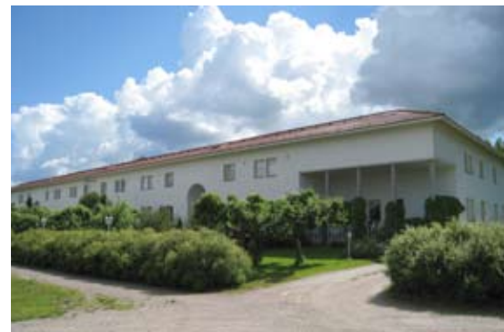
Lohjan Kalkkitehtaan rakennuttama rivitalo 1930-luvulta.
