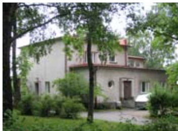
Kalkkitehtaan johtajalle tarkoitettu asuinrakennus vuodelta 1937. Arkkitehti Gösta Cajanus.
